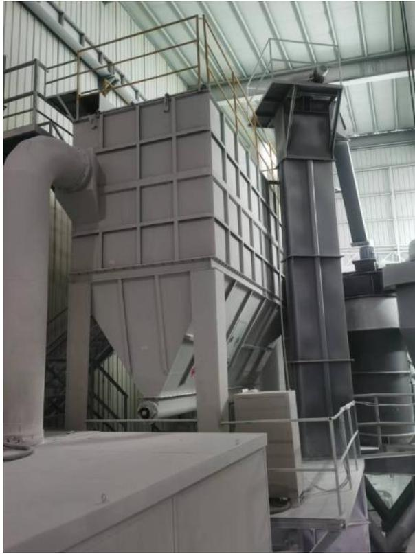
亚微米非金属微粉生产线破碎除尘器
